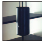
Rozdzielacz linek (już zamontowany)
